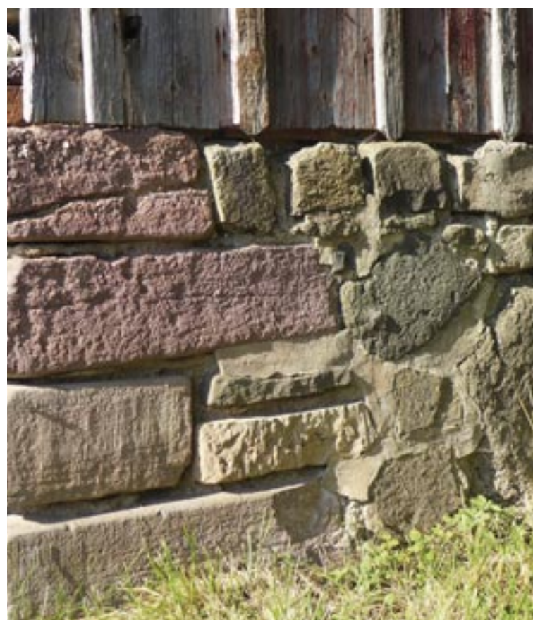
Rötlicher Rhyolith wurde im Sockel des Wirtschaftsgebäudes verbaut. Reddish rhyolite was used in construction of the farm building's foundations.
