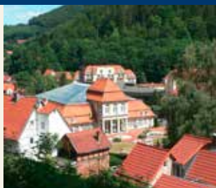
Blick auf Bad Grund
