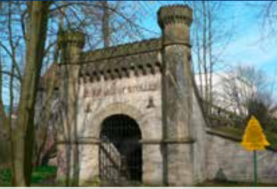
Stollenmundloch in Gittelde
