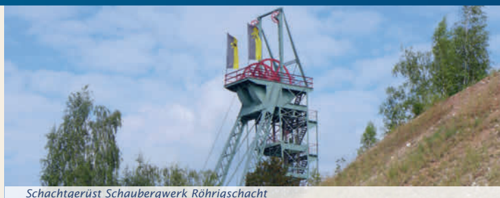
Schachtgerüst Schaubergwerk Röhrigschacht
