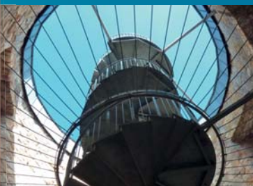
Escalier en vrille de la tour Hausmann
