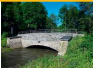
Selkebrücke am Scherenstieg
