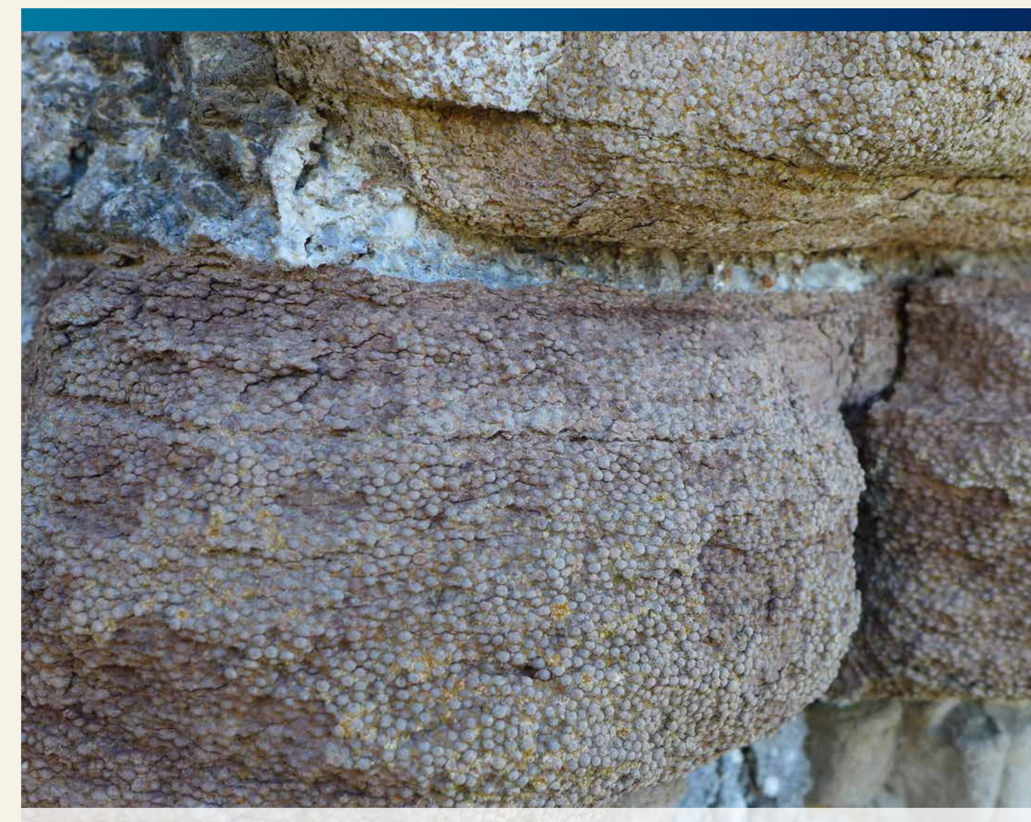
Mauerwerk mit verschiedenfarbigem Rogenstein & Gipsmörtel
