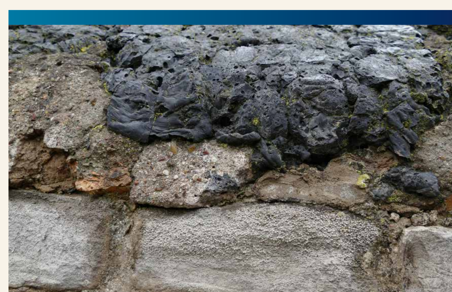
Kirchhofmauer mit Rogenstein & Schlacke
