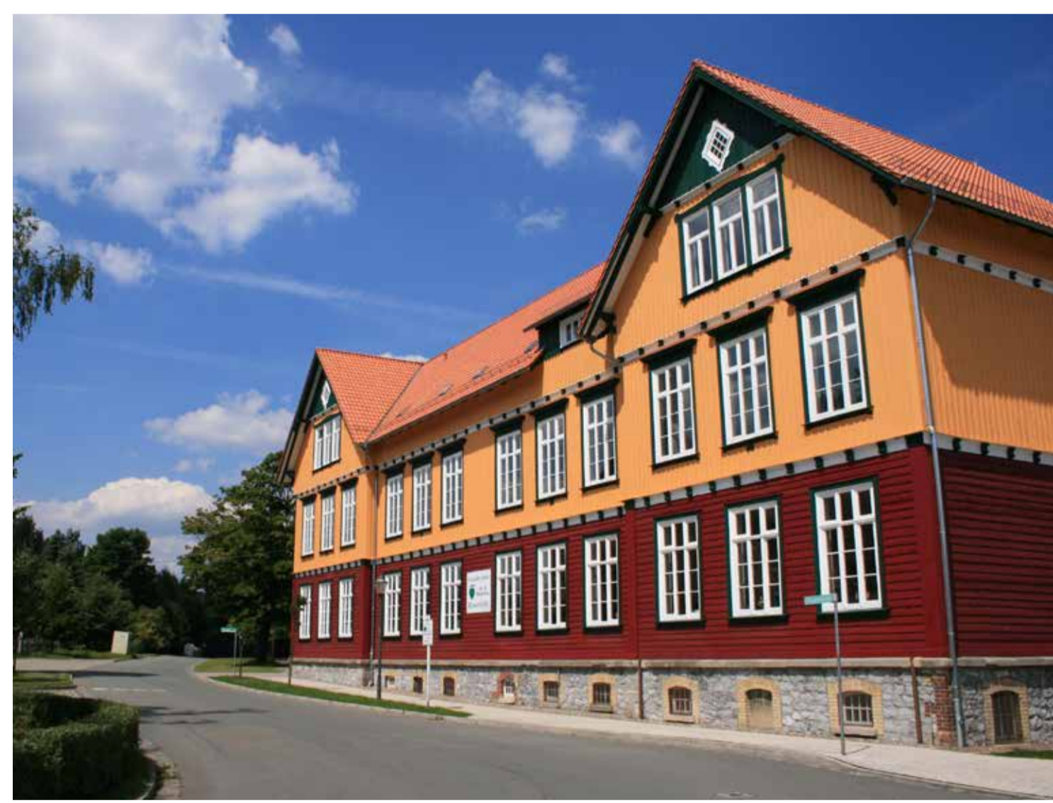
Natursteinsockel Grundschule Hasselfelde
