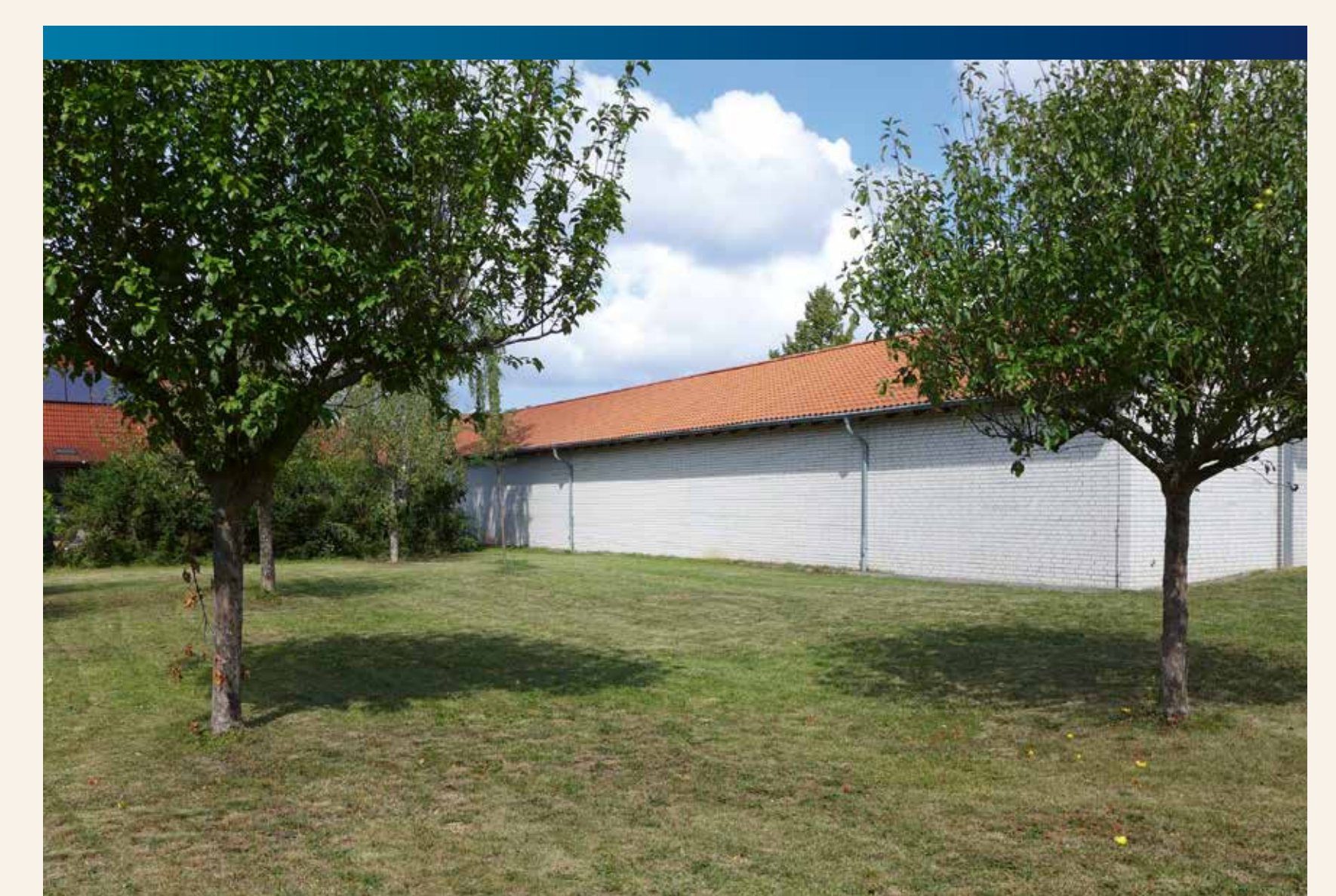
So sah die Fläche neben dem Dorfgemeinschaftshaus vor der Umgestaltung aus.
