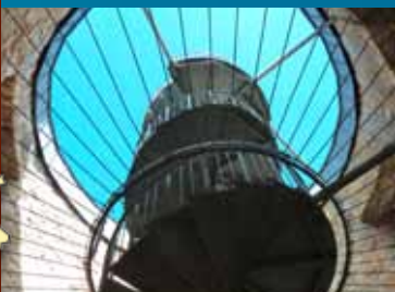
Spindeltrappe i Hausmannsturm
